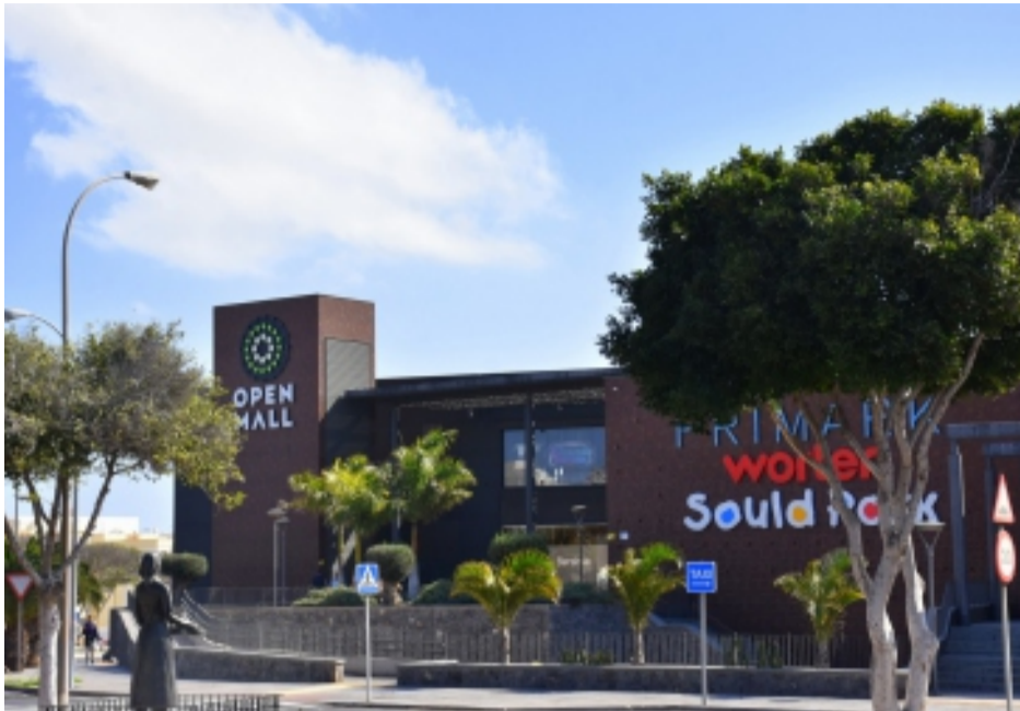
El Open Mall se inauguró en noviembre de 2022 tras una inversión superior a los 80 millones de euros en lo que es una de las principales iniciativas privadas en la mejora urbanística de Arrecife
