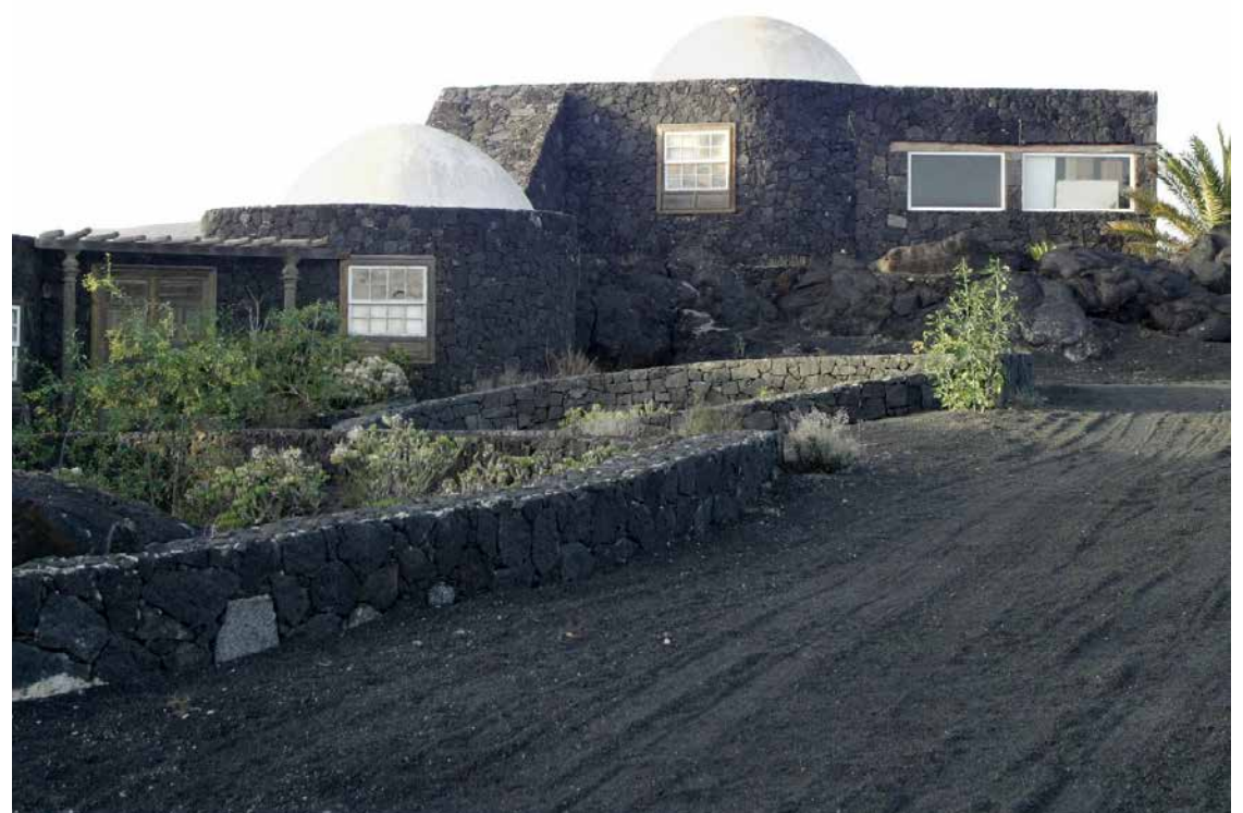
La Casa de las Cúpulas, una construcción de la FCM, con sentencia firme de derribo.
