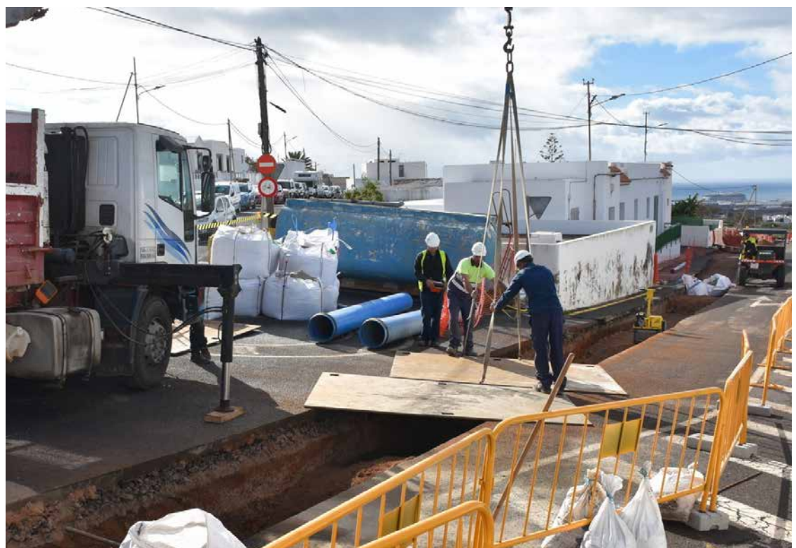
Las averías hacen que se pierda la mitad del agua que se produce.
