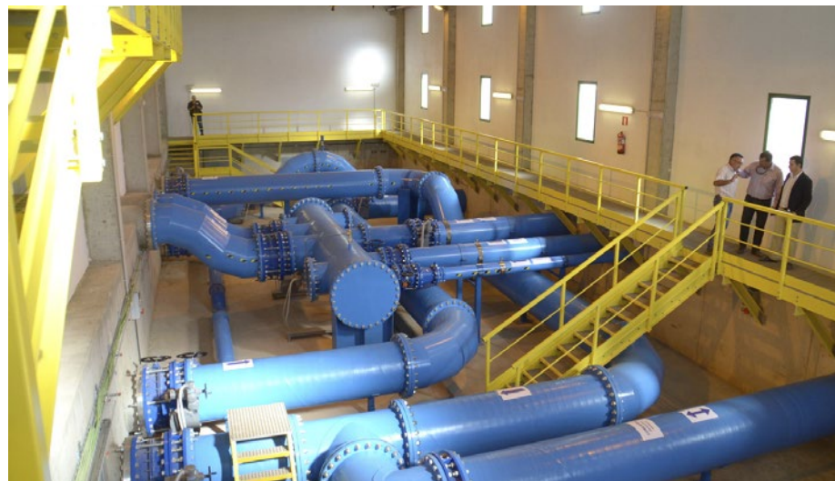
Es preciso mejorar las plantas depuradoras de la isla que se han quedado pequeñas para la actual población.
