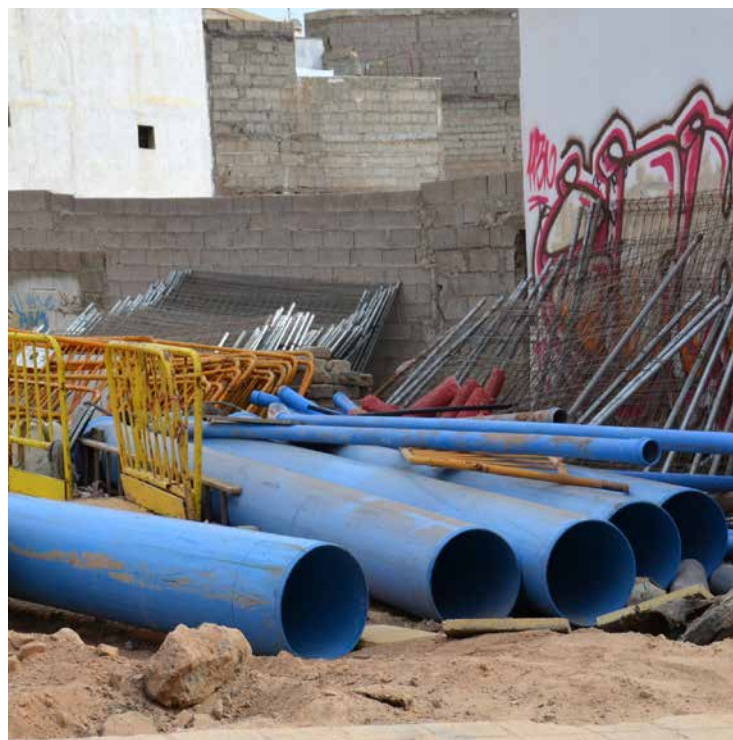
Las tuberías de la isla están obsoletas.
