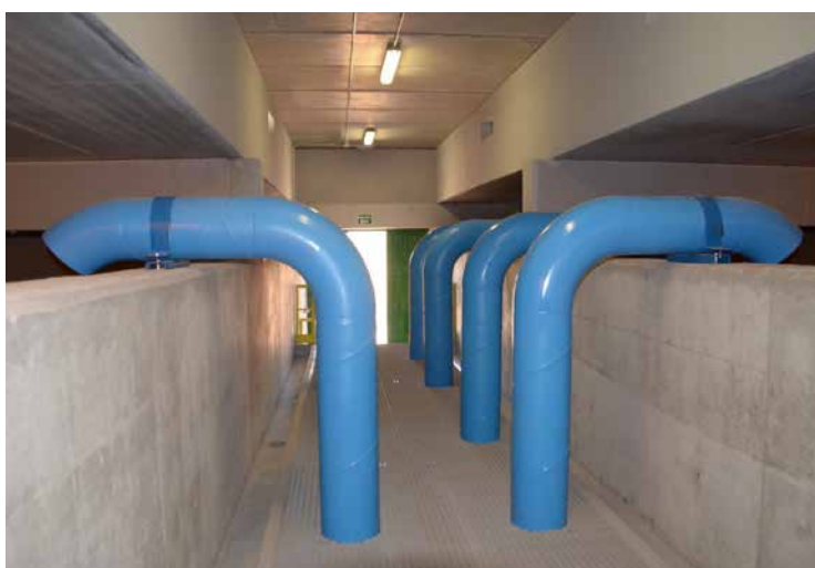
Las pérdidas de agua supera el 60 % de lo que se produce.
