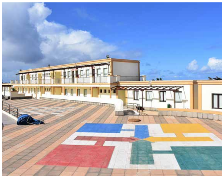
Las instalaciones del albergue de La Santa llevan tiempo siendo reclamadas por los vecinos de
