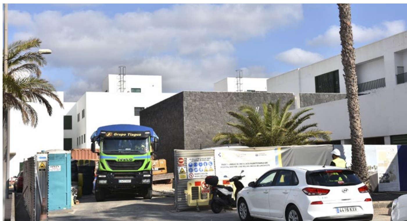
El presupuesto de la obra es de 15.5 millones de euros.
